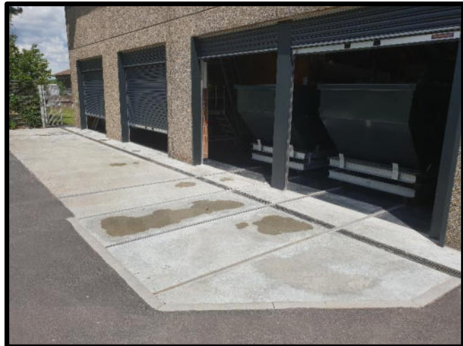
Sanierung Containeranlage Rechenhaus
