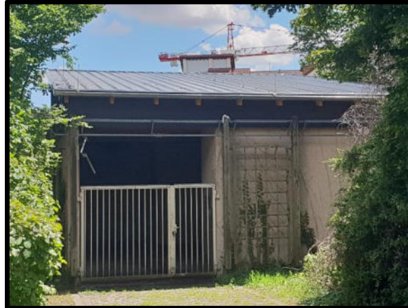
Dacherneuerung RÜB 3 Ebertpark
