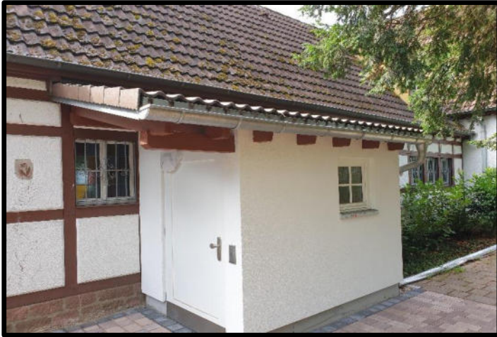
Neubau behindertenfreundliches WC
