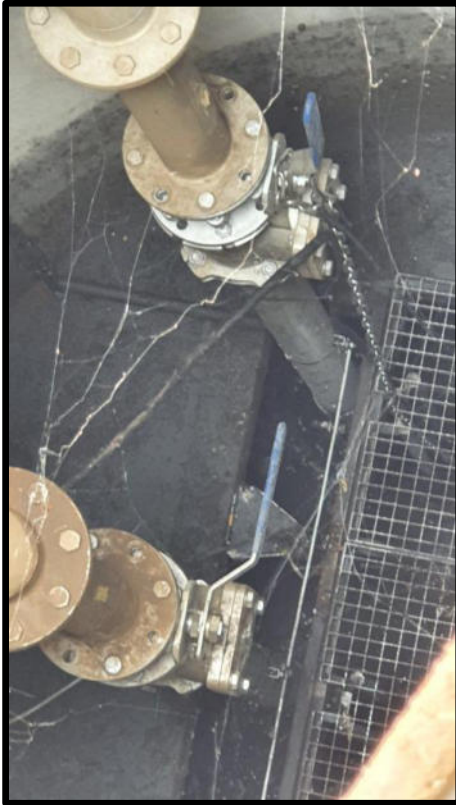
Sanierung Pumpwerk Pfälzer Ring
