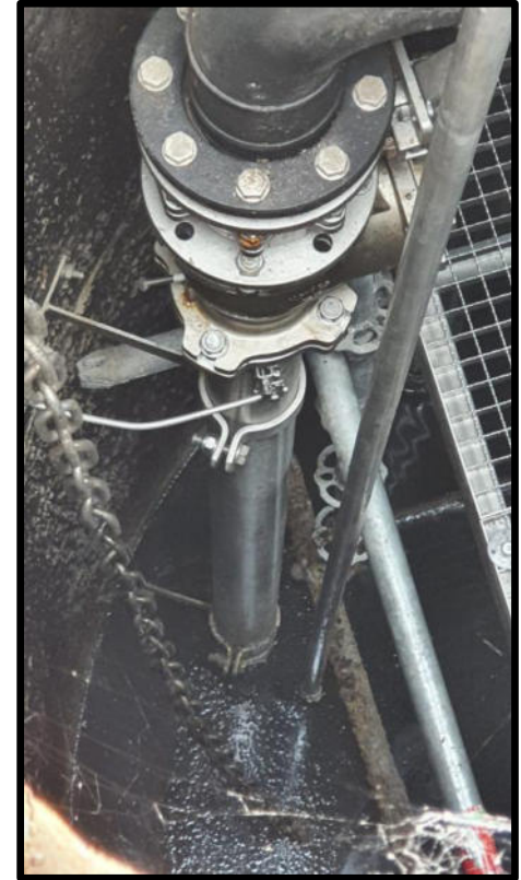
Sanierung Pumpwerk Dänisches Lager
