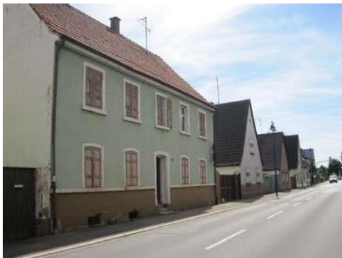
Häufung schlechter Bausubstanz und modernisierungsbedürftiger Fassaden (Bsp. Obere Hauptstraße)
