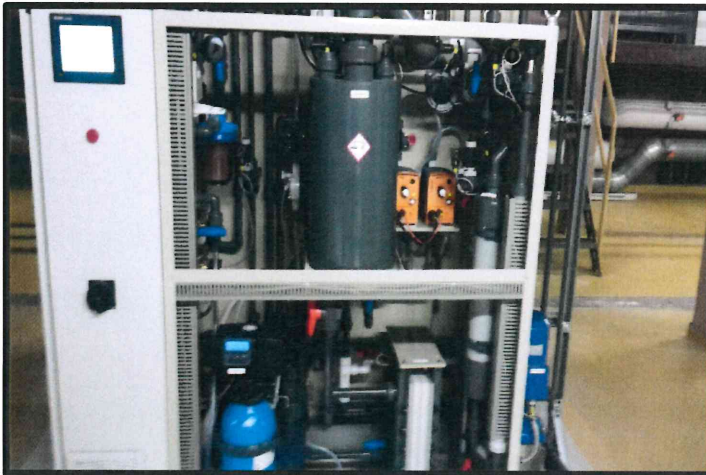
Gymnasium Sporthallen Elektrolyseanlage zur Chlorgaserzeugung
