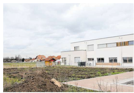
Auf diesem Grundstück neben dem „Haus der kleinen Hasen“ soll mit einer Übergangslösung Raum für mehr Betreuungsplätze geschaffen werden.
