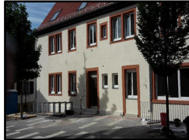
Rückgebäude Lutherhaus Außenansicht
