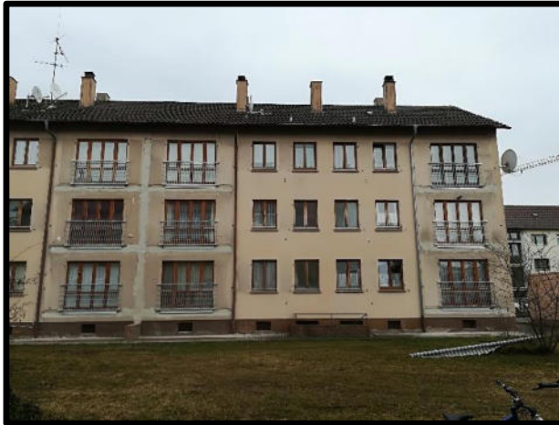
Erneuerung Balkongeländer Bgm.-Hund Str. 11 und 13
