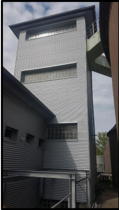
Fassadensanierung Treppenturm Faulbehälter
