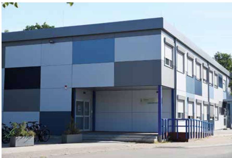
In weiß, blau und grau: Die neue Fassade der Container für die Schule am Kraichbach ist fertig.
