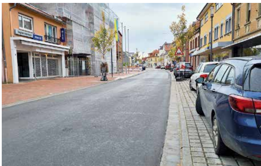
Bereits freigegeben: Zwischen der Fortunakreuzung und der Oberer Mühlstraße fließt der Verkehr schon seit vielen Wochen wieder normal.
