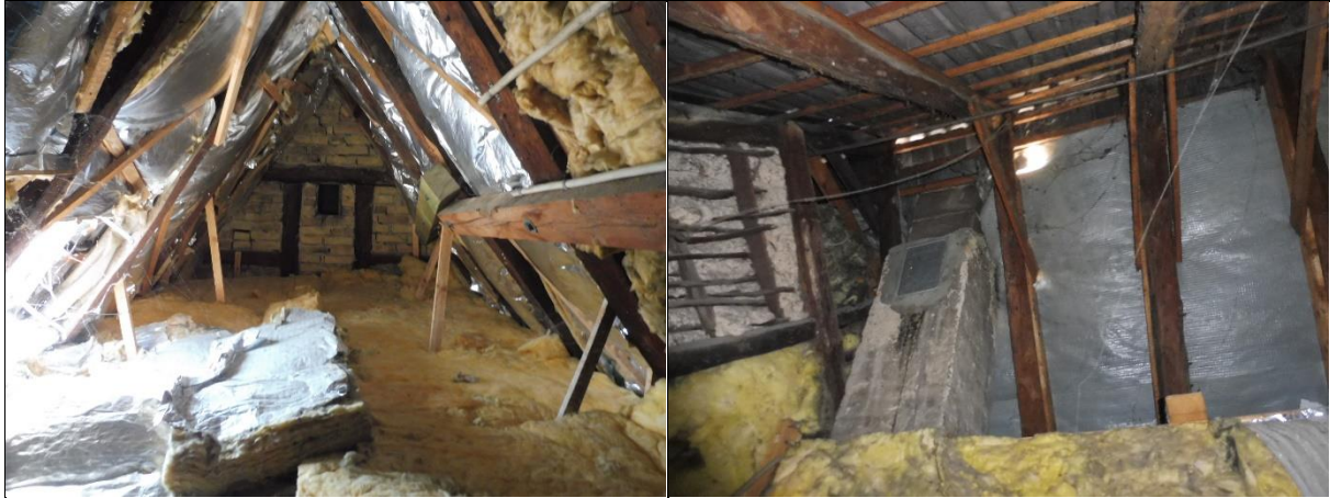
Dachstuhl Wohnhaus Obere Hauptstr. 55
