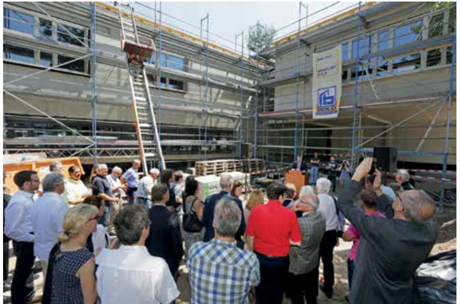
Richtfest für den Neubau der Louise-Otto-Peters-Schule: Das neue Gebäude kostet den Rhein-Neckar-Kreis rund 6,7 Millionen Euro.
