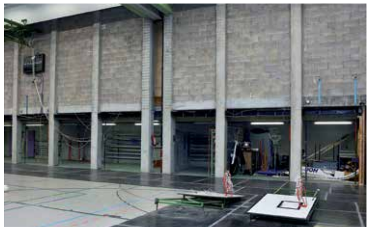
Die Rudolf-Harbig-Halle erhielt neue Prallschutzwände.
