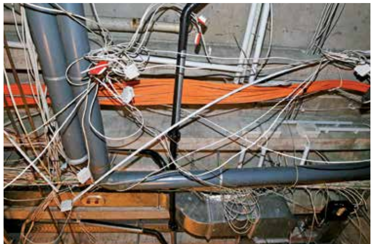
Blick hinter die Decke im Gauß-Gymnasium.
