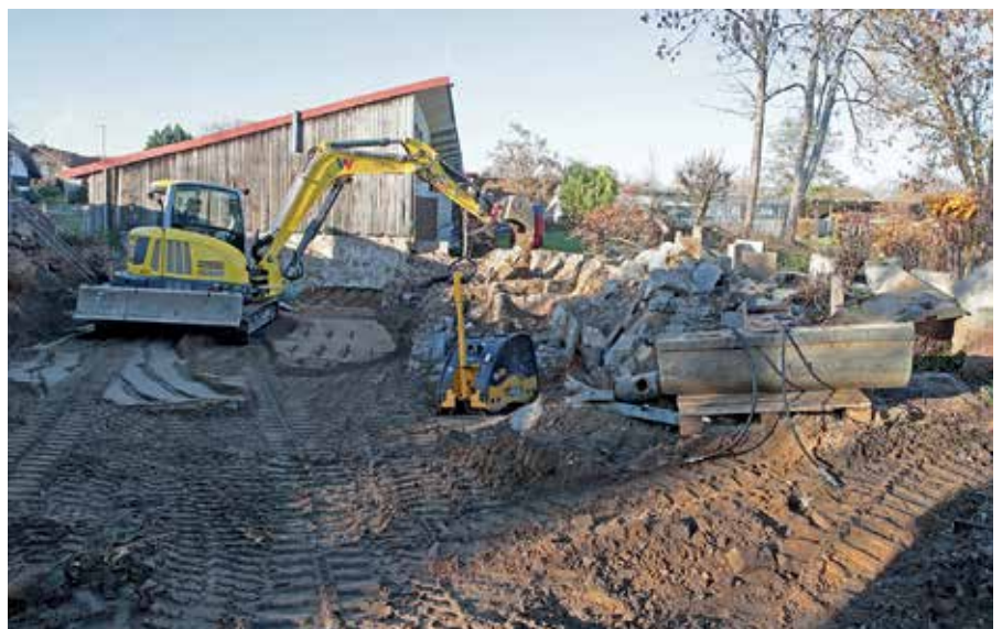
Im Außengelände wurden die Fundamente des alten Filterhauses ausgegraben, um Platz für die neue Werkstatt zu machen.
