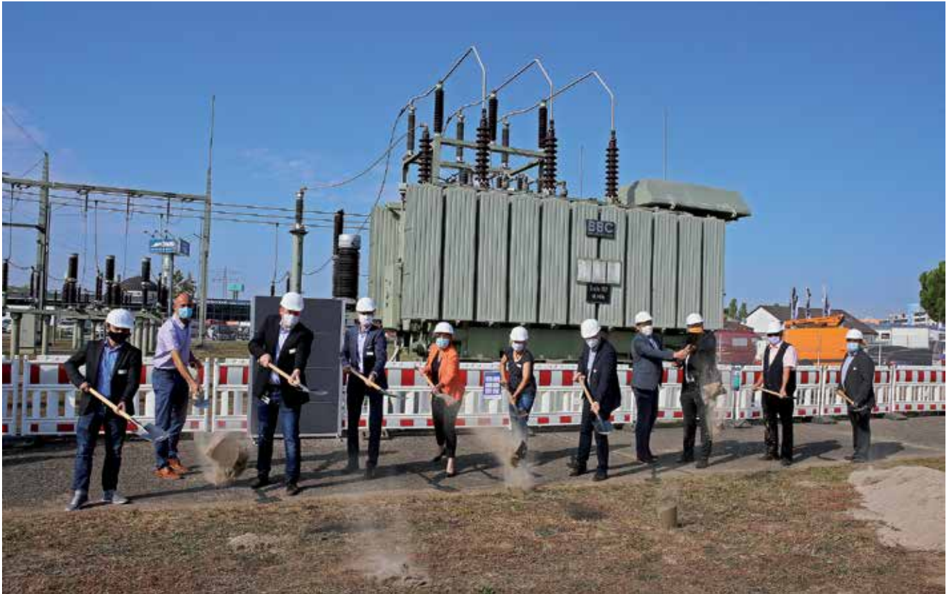
Begingen feierlich den Spatenstich für die Erneuerung des Umspannwerks in Hockenheim-Talhaus: Martin Borzutzky (Omexon), Michael Sauter (Stadtrat), Sascha Sauer (Projektleitung EnBW), Timo Schmitt (Vertriebsleitung EnBW), Martina Wilk (Leitung Stadtwerke Hockenheim), Marina Nottbohm (Stadträtin), Dr. Martin Konermann (Netze BW-Geschäftsführer), Bürgermeister Stefan Weisbrod (Reilingen), Oberbürgermeister Marcus Zeitler (Hockenheim), Fritz Rösch (Stadtrat) und Erhard Metzler (Leitung Stadtwerke Hockenheim) (v.l.n.r.).
