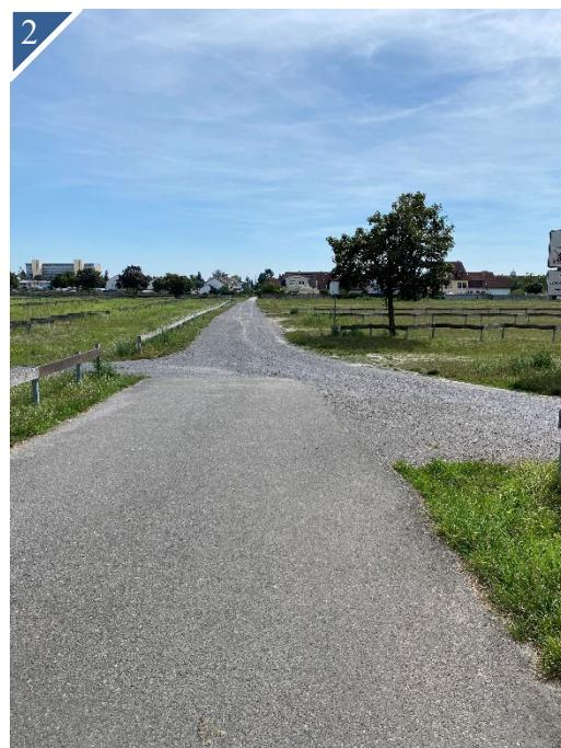
Hier dokumentiert ist der Übergang von dem asphaltierten Teilstück in den Bereichen 1 und 2 hin zu den nicht umfänglich befestigten Fahrwegen, in denen Schotter / eine wassergebundene Decke die Fahrgasse bildet.
