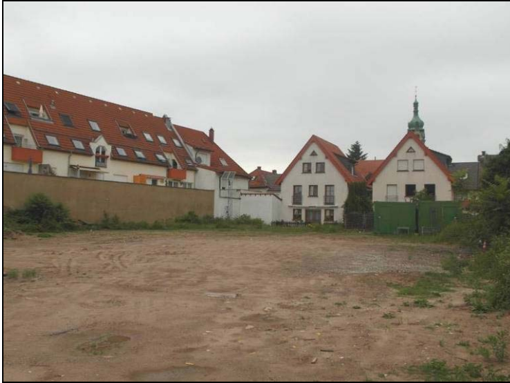
Abbildung 3: Nach Gebäudeabriss planierte Fläche
