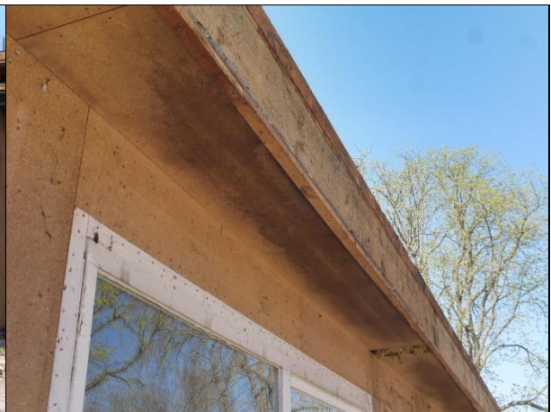
Entfernte Fassadenverkleidung
