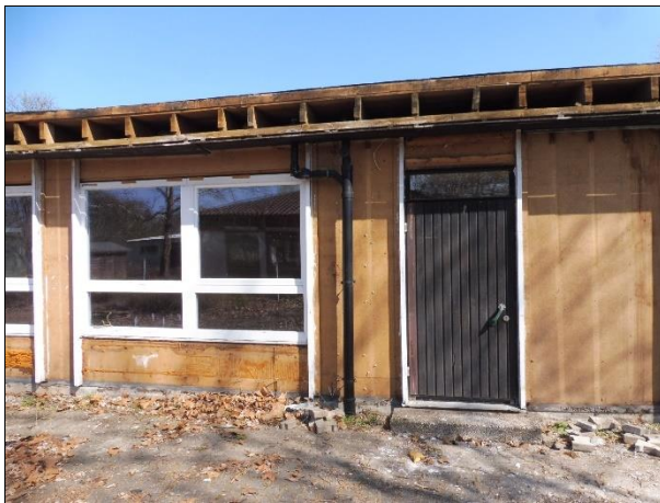
Entfernte Fassadenverkleidung
