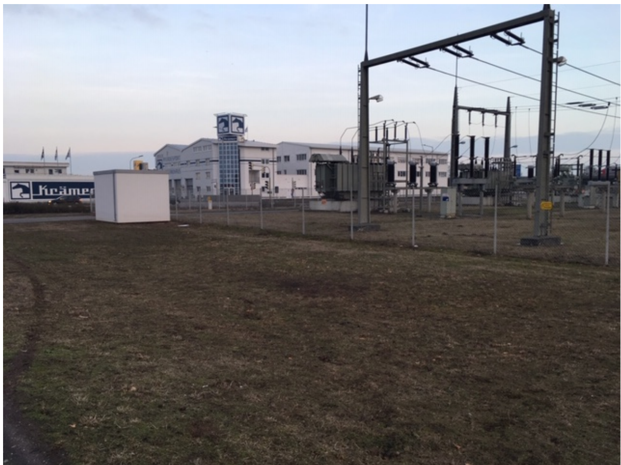
Abbildung: geplante Erweiterungsfläche | Eigene Aufnahme Januar 2019
